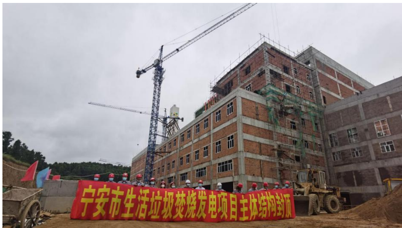
宁安市生活垃圾焚烧发电项目主体结构封顶
